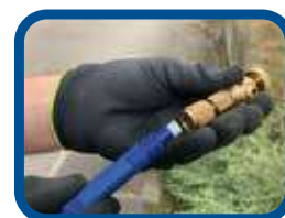
Colocación de nueva junta
